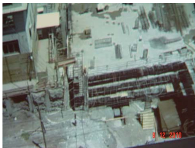
Estacionamientos subterráneos Plaza Ñuñoa, Santiago
