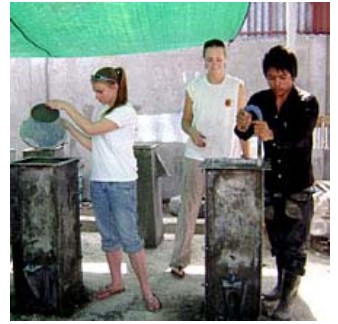
Interactianos de Jackson Hole, Wyoming, EE.UU., instalan filtros de arena en una aldea de Camboya. Foto: Distrito 5440
